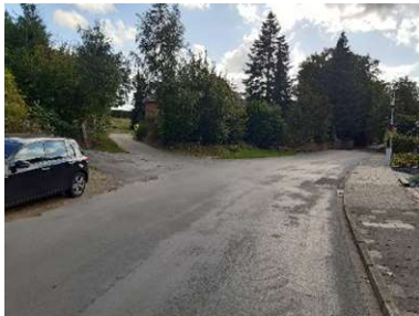
Abb. 6: Einmündungsbereich der Straßen Mühlenbreite / Zum Attersee
