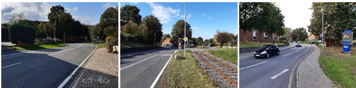
Abb. 8 bis 10: Einmündungsbereiche der Straßen Bergstraße / Mühlengrund / Atterstraße
